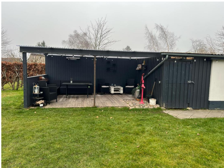
Figur 3: Billede af bebyggelsen. Overdække til venstre og skur til højre.
